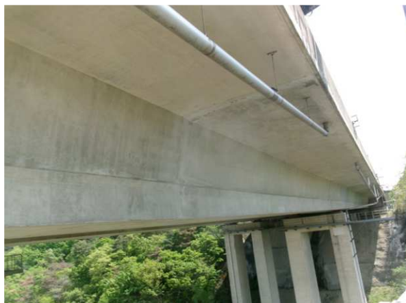
PSC BOX 외부 전경
