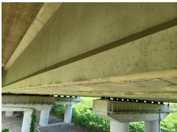
PSC Girder 전경
